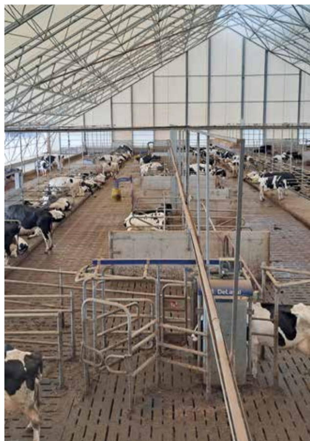
Separací branka rozděljuje dojnice na dojení nebo na krmení.
