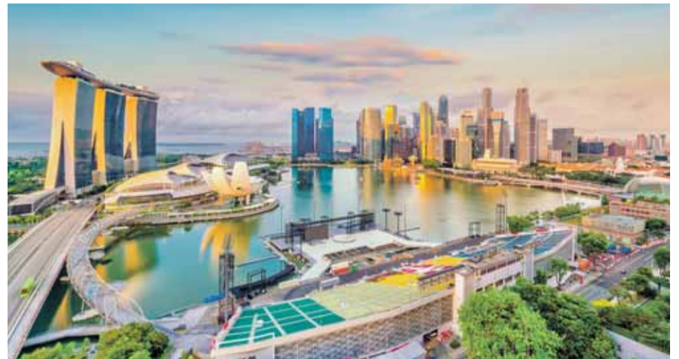
Voda je i uvnitř ostrova na Singapuru všudypřítomná.
