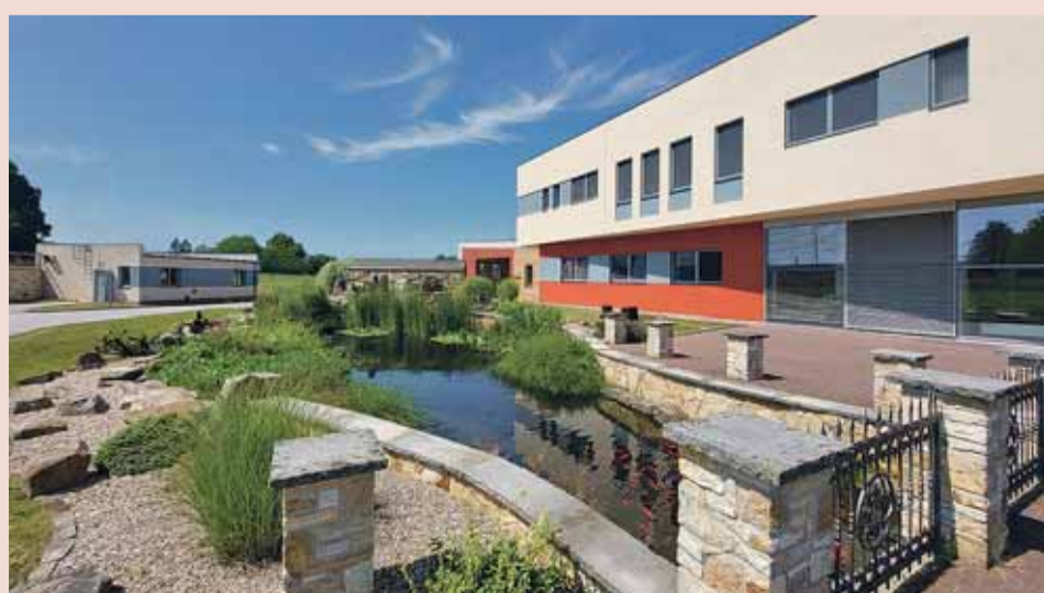
Moderní budova a provoz pekárny Beas
