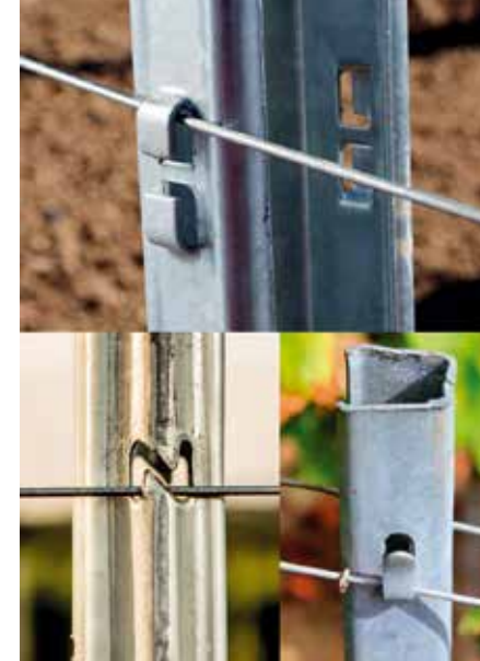
Obrázek 4: Uchycení dvojdrátí systémem vnitřních nebo vnějších háčků
