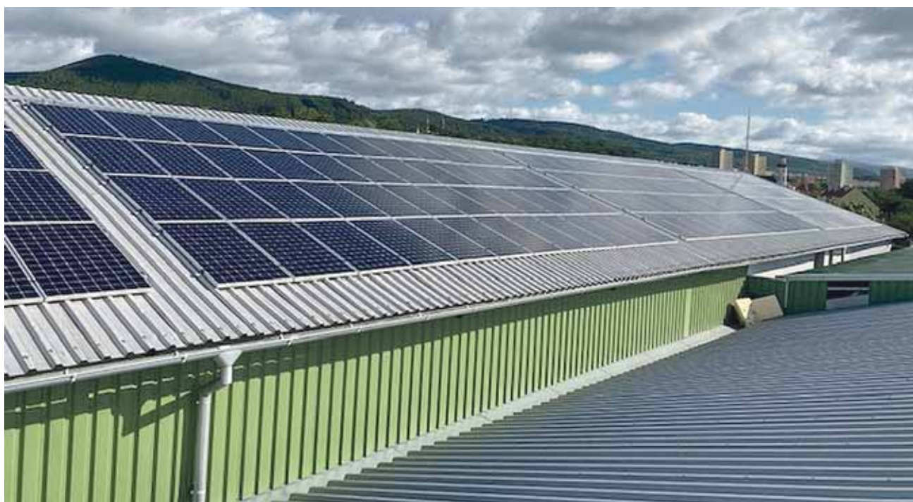
Fotovoltaické panely dotují elektřinou chladicí agregáty ve skladech ovoce.
