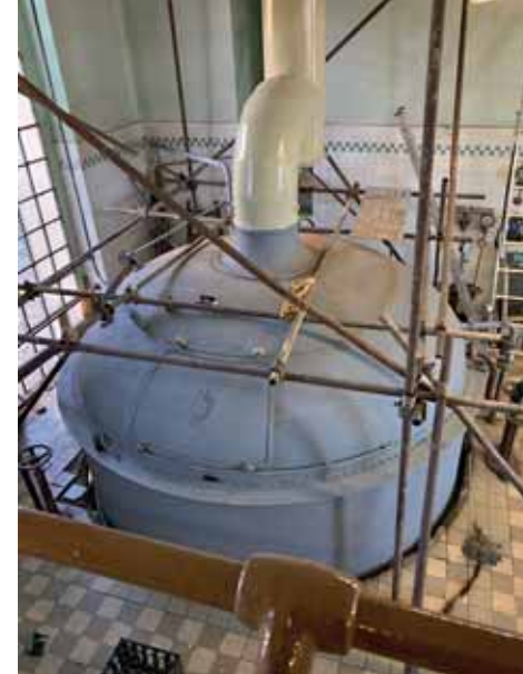
Varna v procesu renovace
