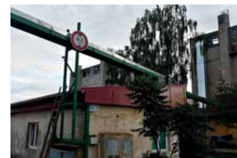
Horizontální dopravník mezi česačkou a sušárnou, v pozadí vertikální dopravník na stěně sušárny
