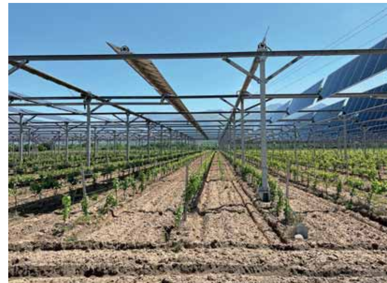
Obrázek 2 - Agrivoltaická vinice v blízkosti města Perpignan v jižní Francii. Na obrázku je patrné testování různého náklonu, tedy propuštění světla na vinnou révu.
