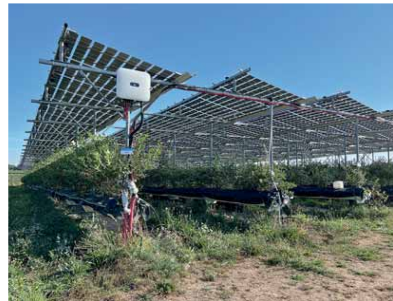
Obrázek 4 - Agrivoltaický systém ve spojení s pěstováním borůvek. Konkrétně tento systém je doplněn o systém směru dešťové vody.
