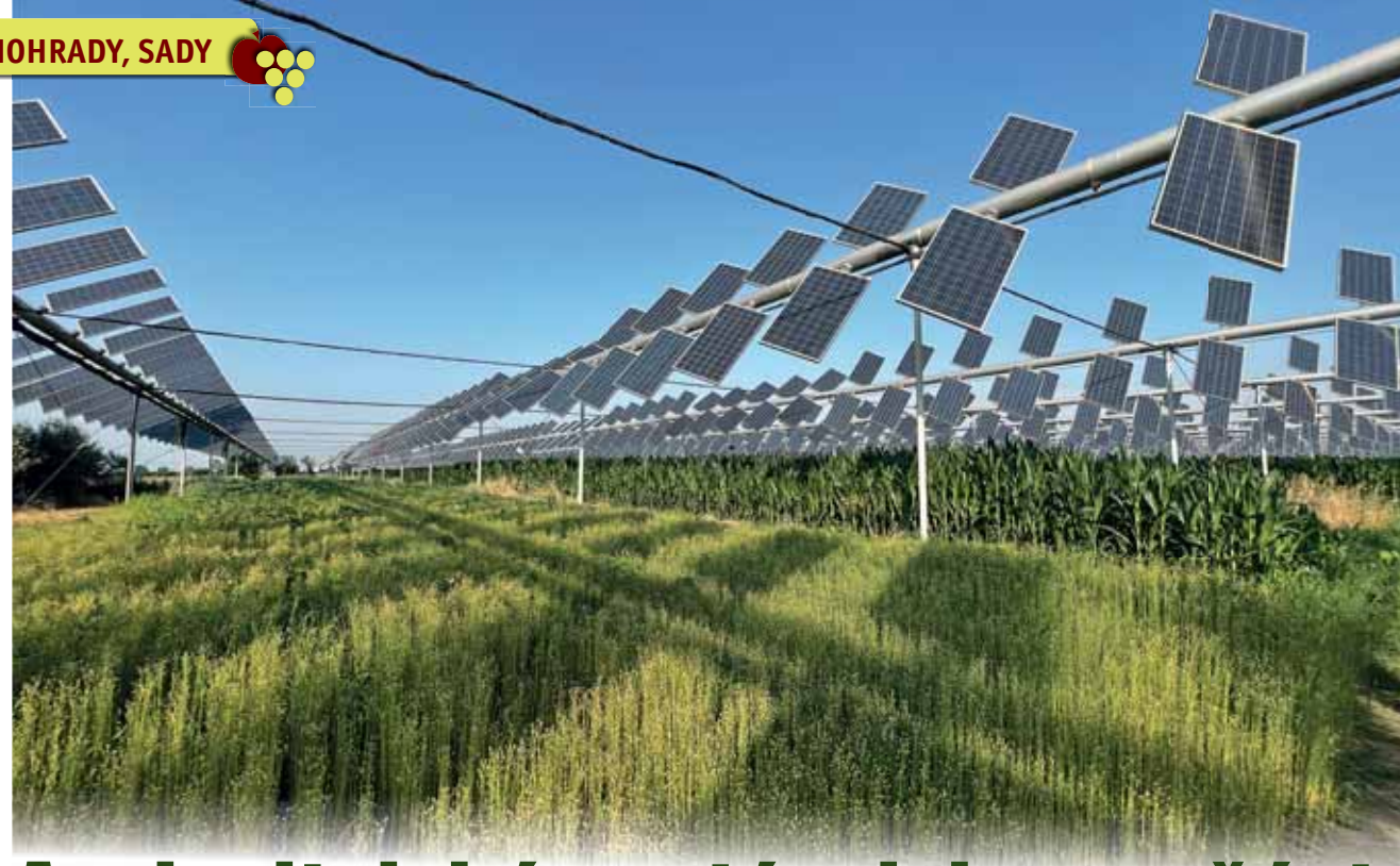
Obrázek 1 - Pilotní projekt agrivoltaického systému nad kukuřicí v Piacenza v Itálii [4]
