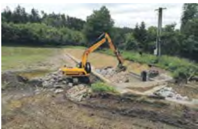
Vodní plocha prochází rekonstrukcí, za 5,7 milionu.
