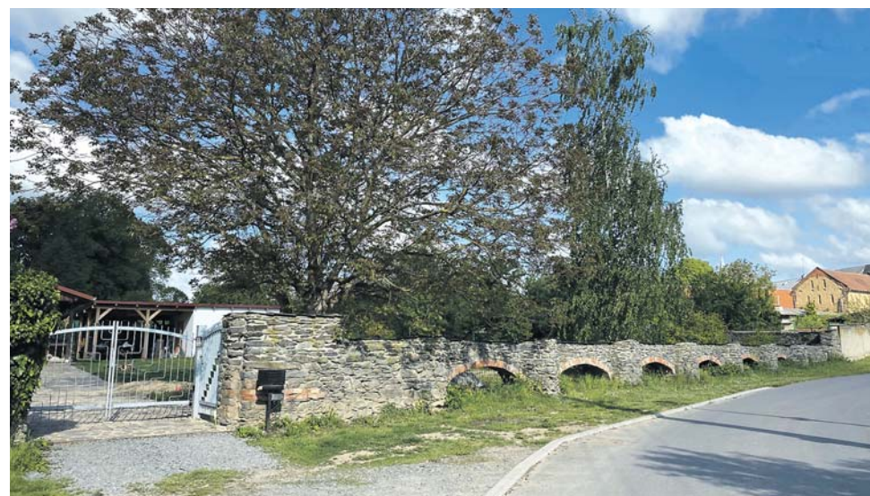
V Seničce najdeme zajímavou technickou památku. Protipovodňová zídka byla postavená v roce 1849, a její autoři se inspirovali v Itálii, kde Češi bojovali.
