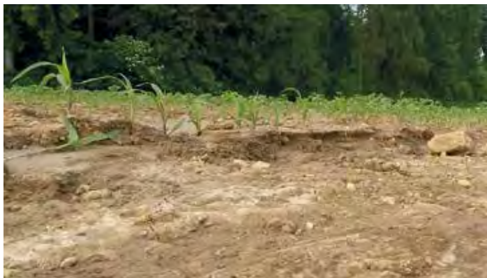
Zhutnění odkryté přivalovými srážkami
