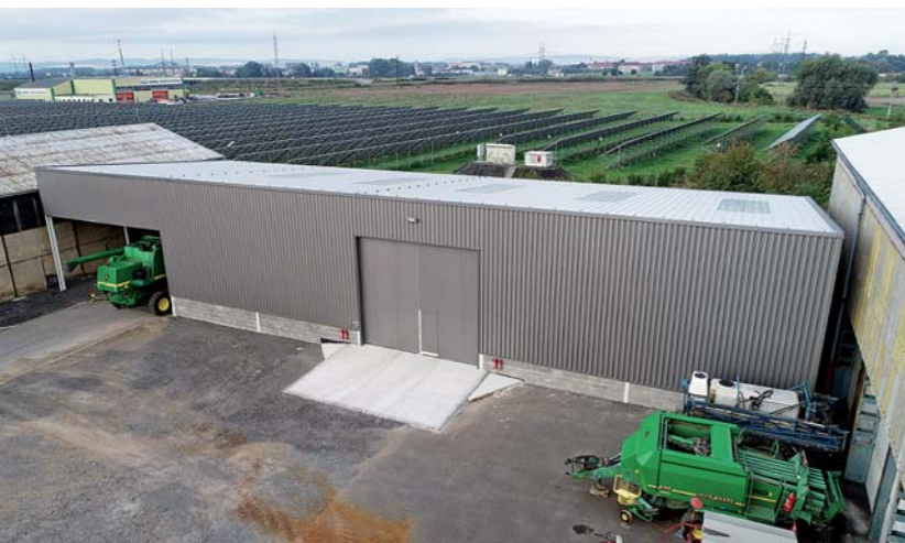
Zemědělská skladová hala Pravčice 16x43m
