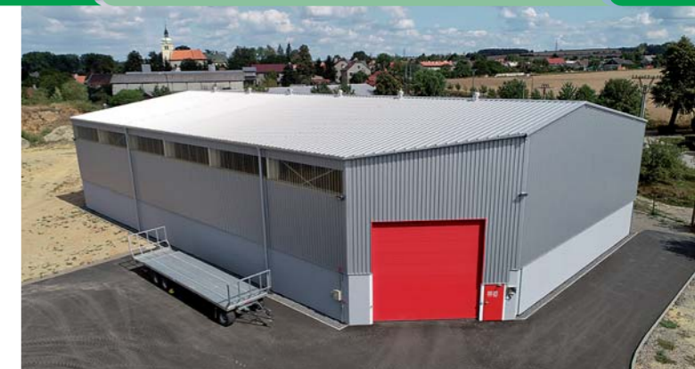
Skladová zemědělská hala ZS Pobečví 25x45m
