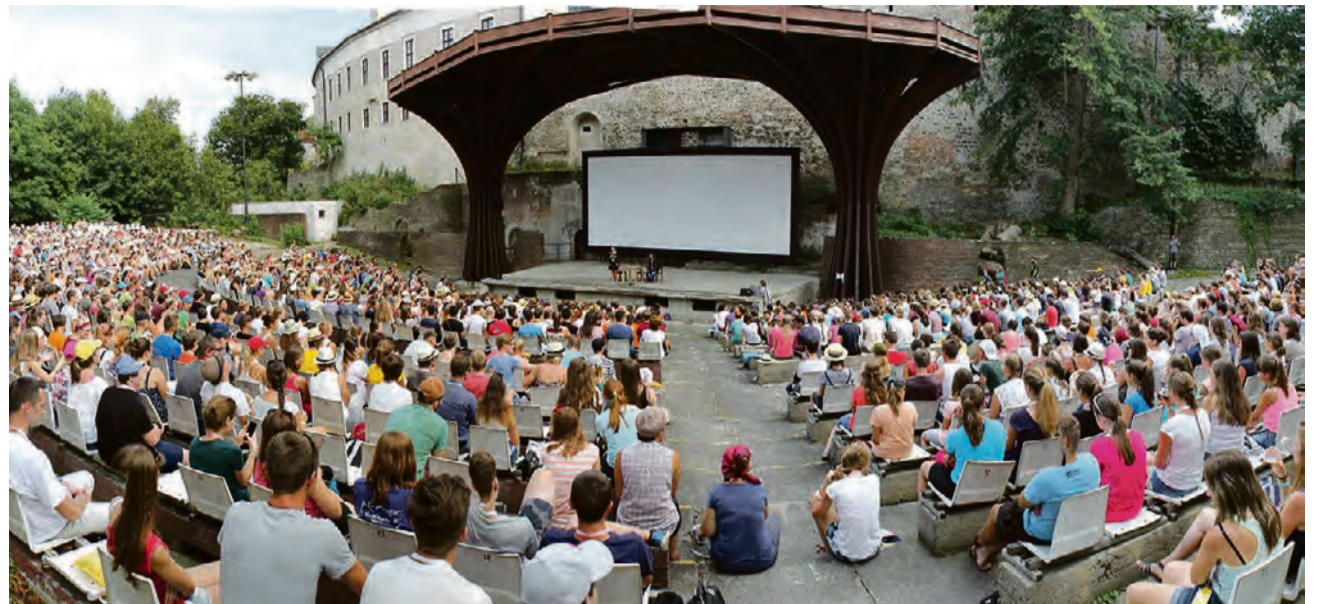
Dřevěné zastřešení pódia a plátna olomouckého letního kina znali diváci 32 let. Oprava není možná, a tak konstrukci čeká demolice.
