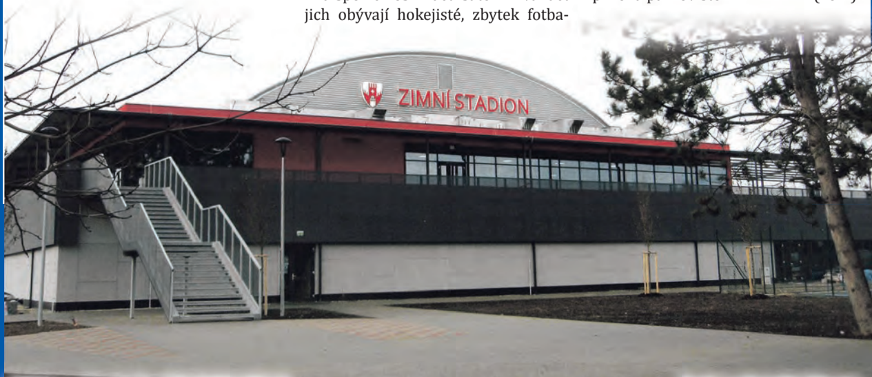
Pohled na nový zimní stadion v Mlýnské ulici ve Vyškově.
