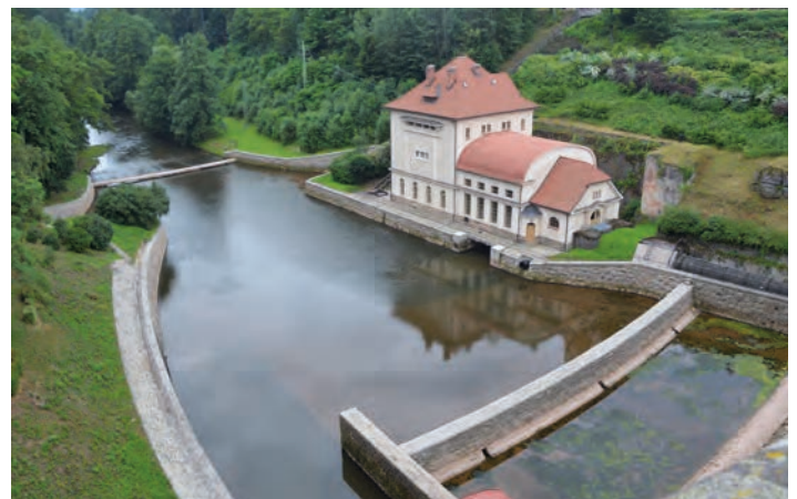
MZe se angažuje ve výstavbě nových přehradních nádrží.
