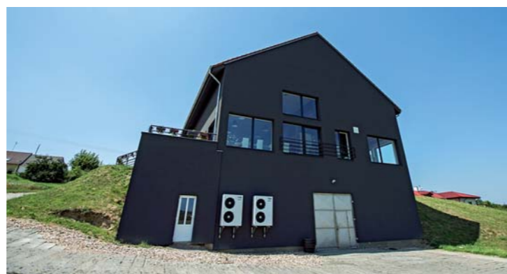
Vinařská budova rodinného Vinařství Škrobák
